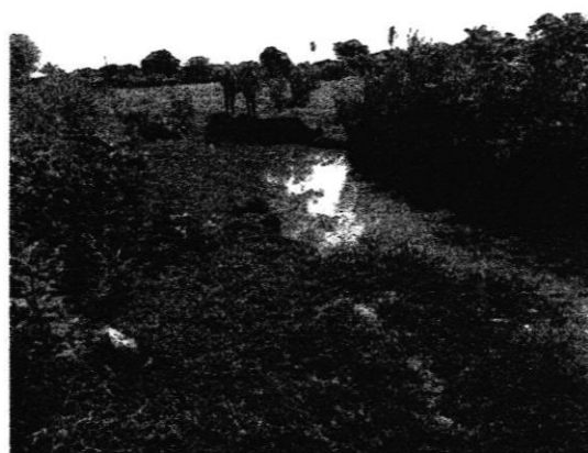
FIGURA 35: DISSIPADOR DE ENERGIA FORMANDO CANAL 02.
